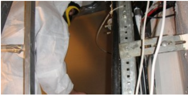
Feinreinigung bei Asbestsanierung
