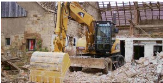
Komplettabbruch eines Wohhauses
