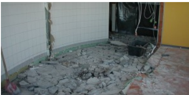
Entkernung im Sanitärbereich
