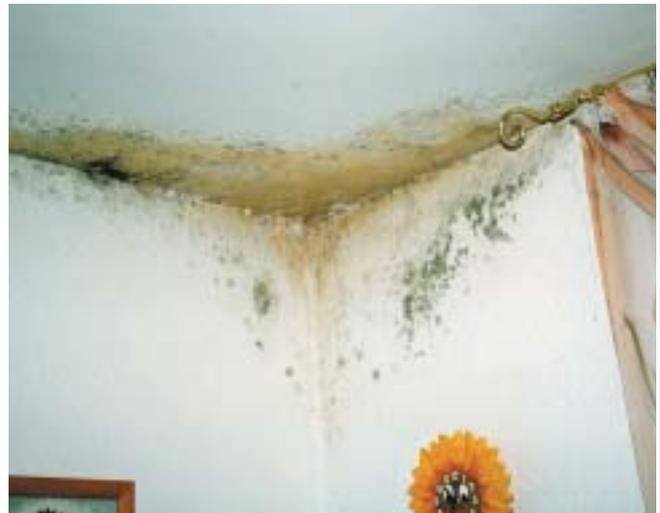
Bild 4: Schimmelpilzbefall undichtes Flachdach
