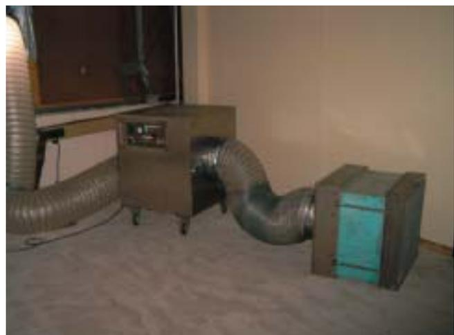
Bild 9: Technische Entlüftung bei starkem Schimmelpilzbefall
