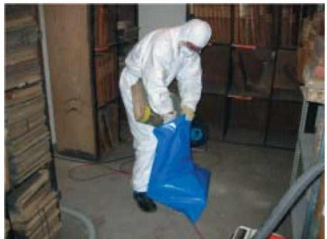
Bild 7: Beispiel für mittlere Sporenexposition (Gefährdungsklasse 1 oder 2, je nach Dauer der Tätigkeit) beim Verpacken von mit Schimmelpilzen kontaminiertem Archivgut, das zuvor oberflächlich abgesaugt wurde
