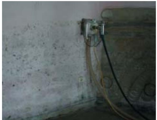
Bild 6: Besser ist es, den Schimmelpilz durch ein Sprühextraktionsverfahren zu entfernen. Dadurch verringert sich die Sporenexposition und die Tätigkeit kann in eine geringere Gefährdungsklasse entsprechend Abschnitt 5.2.1 eingestuft werden (mittlere Sporenbelastung → Gefährdungsklasse 2)
